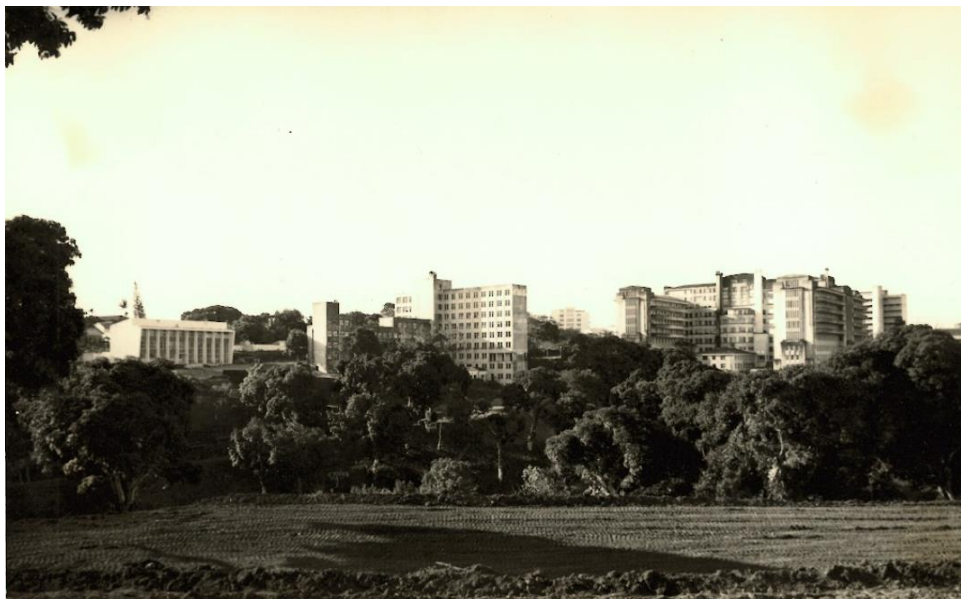
Figura 10 – Fotografia de 1957 com edifícios da Universidade da Bahia ao fundo, sendo da esquerda para direita: Casa da França, Escola de Enfermagem e o Hospital das Clínicas. Em primeiro plano, a terraplenagem do Vale do Canela.
