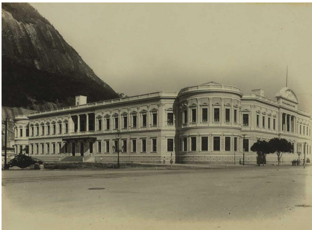
Figura 2: Edifício da Faculdade Nacional de Medicina, nos anos seguintes à sua inauguração (circa 1920). O acesso principal era feito pela escadaria coberta na fachada lateral (à esquerda). Fonte: Brasiliana Fotográfica, Biblioteca Nacional.
