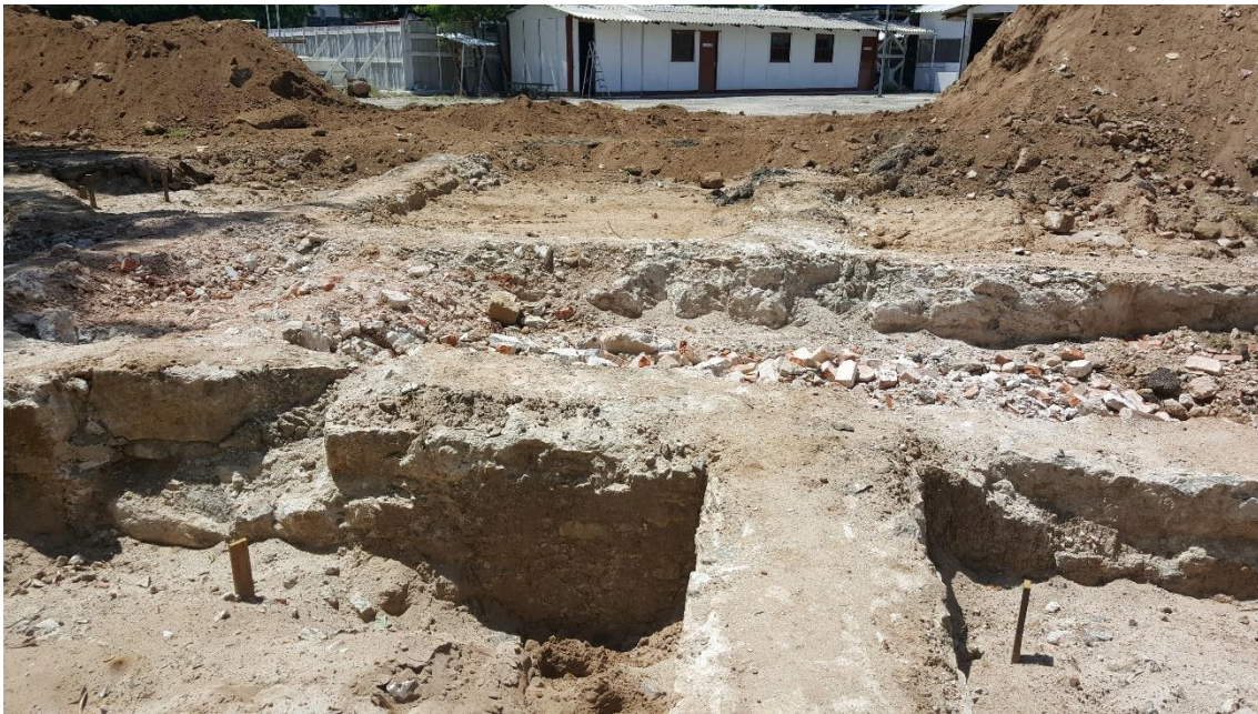
Figura 16: Baldrames da antiga FNM, encontrados durante escavações no Campus Pasteur 458 para a construção do novo prédio do Centro de Ciências Humanas e Sociais (CCH), em 16 de janeiro de 2017. Fonte: Coordenadoria de Engenharia da UNIRIO.
