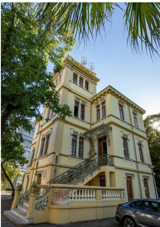
Figura 1 - Prédio da Rádio da Universidade, Campus Centro da UFRGS. Fonte: Acervo SPH, 2018. Crédito: César Vieira
