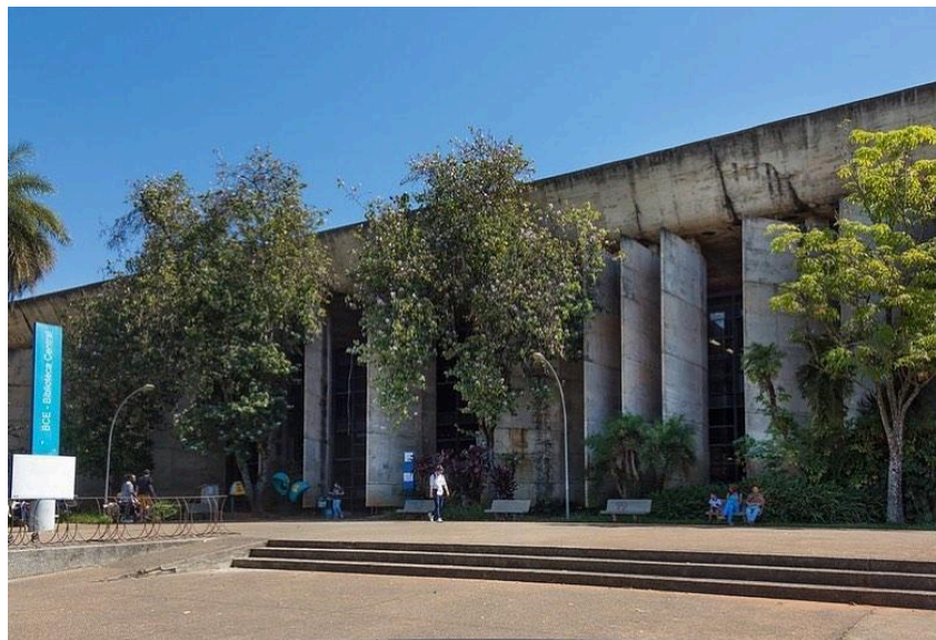
Figura 2. Uma das entradas do Instituto de Central de Ciências.
