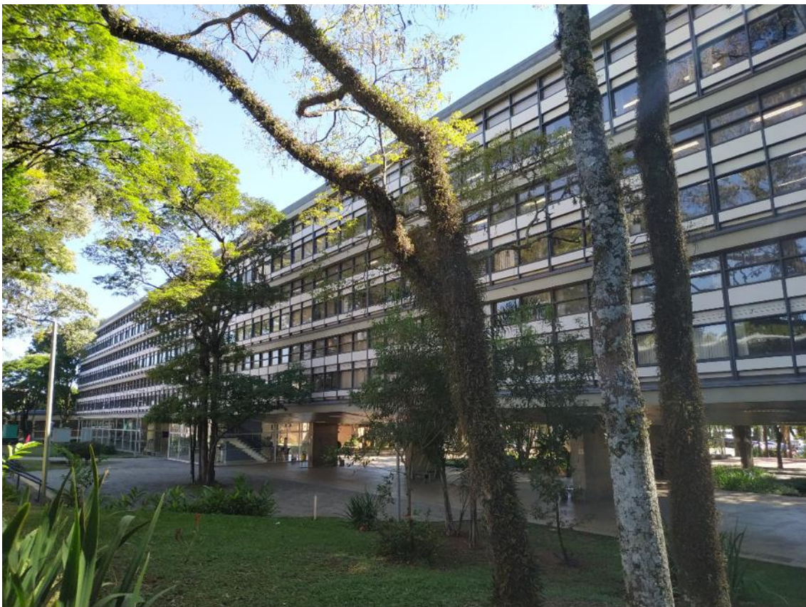
Fig. 1: Vista parcial da fachada norte do E-1. Foto dos autores, 2020.
