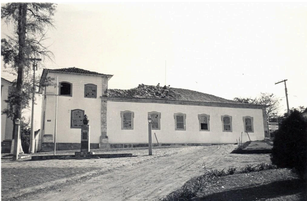
Figura 3: Serviços no telhado, 1981. Fonte: IEPHA.
