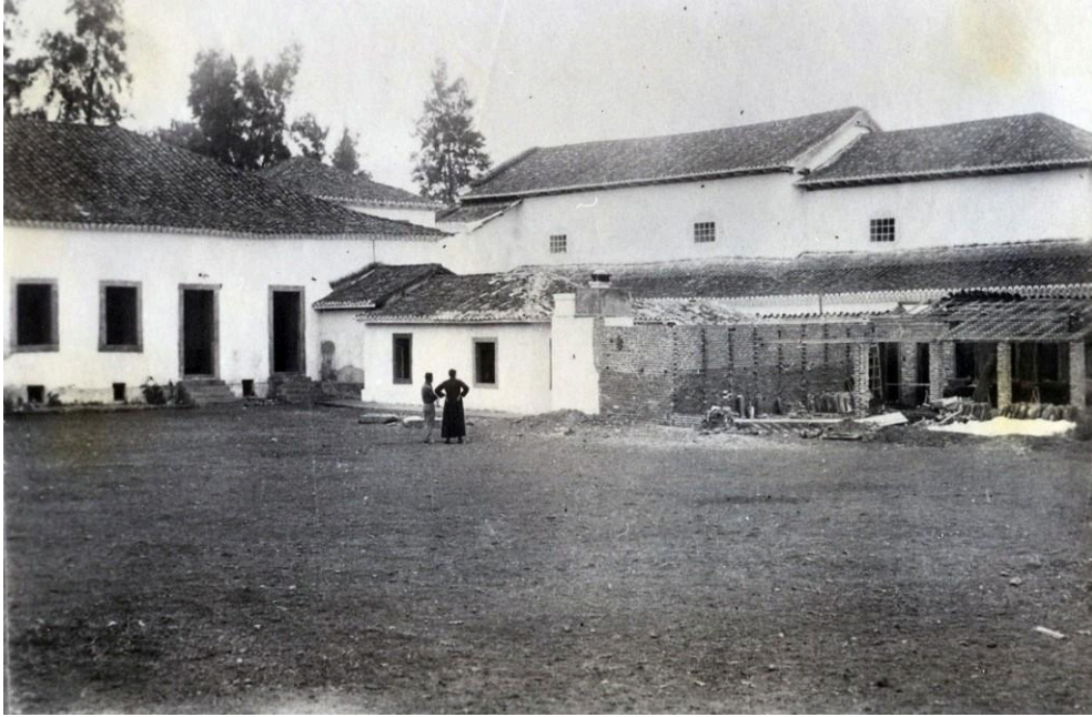
Figura 2: Construção dos anexos dos fundos do solar, década de 1960. Fonte: Sphan.
