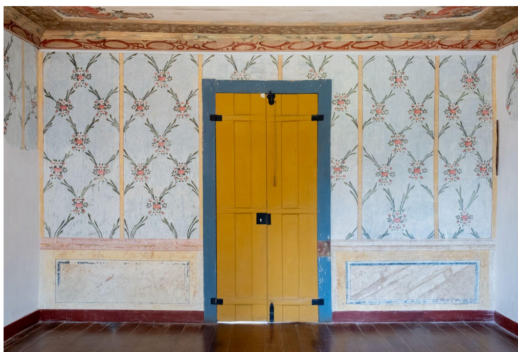
Figura 6: Resultado final da restauração artística de uma das paredes do Torreão, 2023. Fotografia: Alberto Lopes.
