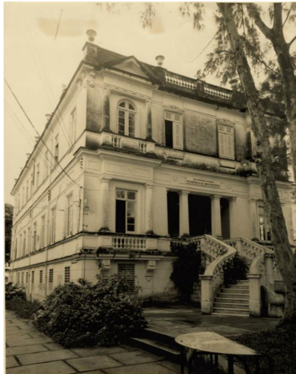
Figura 14 – Fachada principal da antiga Residência Masculina, no Corredor da Vitória.
