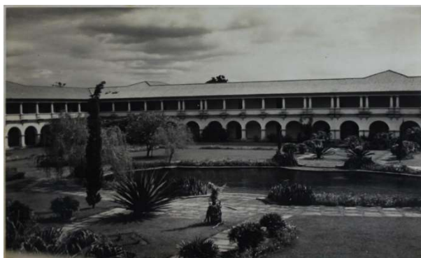
Figura 06 – Sequência de fotos do Pavilhão Central: fachada principal, Auditório Principal e Jardim interno. Relatório de Obras de 1952. LabDoc/ UFRRJ.
